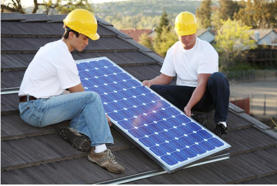
Şekil 20 Güneş Paneli Montajı
